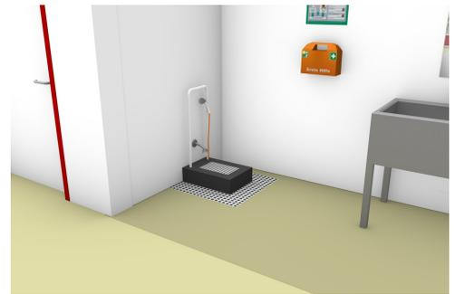
Stiefelwaschanlagen gibt es in drei unterschiedlichen Ausführungen, ortsfest zum bodenbündigen Einbau im Fußboden eines Feuerwehrhausneubaus, in Überflurausführung zum Nachrüsten bestehender Feuerwehrhäuser und ortsbeweglich.
